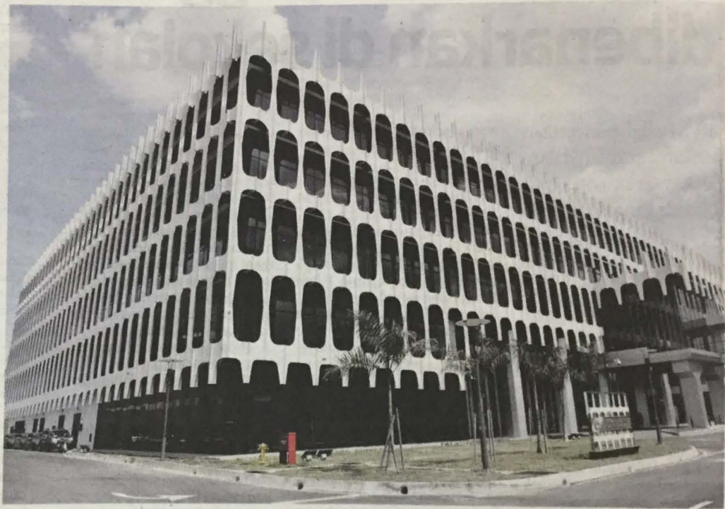
Bangunan Parlimen Fasa 3B yang dinaik taraf dan dibaik pulih sejak 2015 akan mula beroperasi pada Mac ini.
