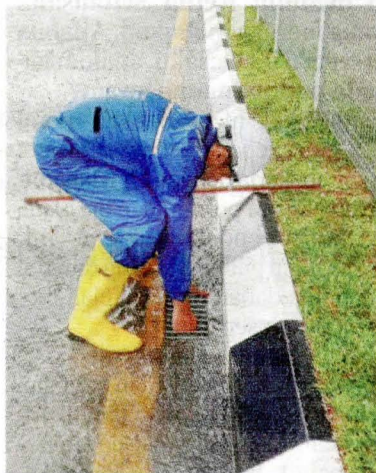
Petugas DBKL membersihkan saluran yang tersumbat di Jalan Besar Kepong.
