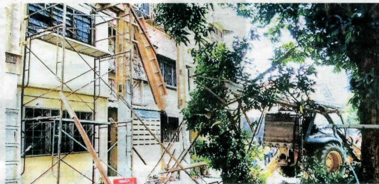
KERJA-KERJA ubah suai yang dijalankan melibatkan penambahan bilik di aras dua di belakang flat di Bandar Baru Sentul, Kuala Lumpur.
