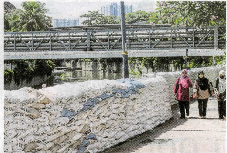
DBKL menempatkan benteng guni pasir bagi menghalang limpahan air Sungai Gombak ketika hujan lebat di Jalan Batu Bata, Kuala Lumpur.
