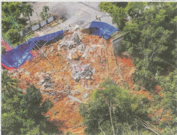
Langkah segera JKR dengan memasang kanvas di lokasi berjaya mengelakkan kejadian tanah runtuh lebih serius.
