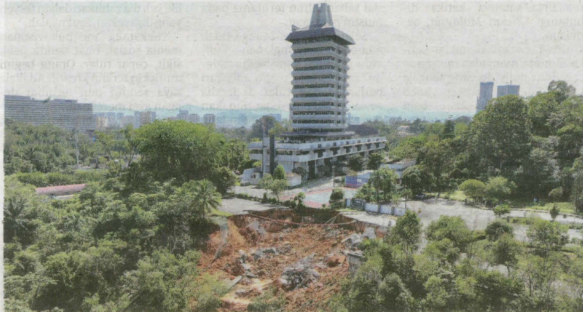
TINJAUAN tanah runtuh di Akademi SPRM, Jalan Duta, Kuala Lumpur, semalam. - UTUSAN/SHIDDIEQIIN ZON
