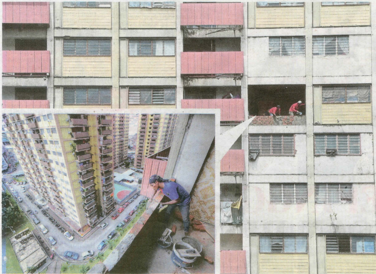
KONTRAKTOR DBKL membaiki pulih dinding bilik rumah mangsa yang tercabut di Perumahan Loke Yew yang terjejas akibat ribut dan hujan lebat, kelmarin.
