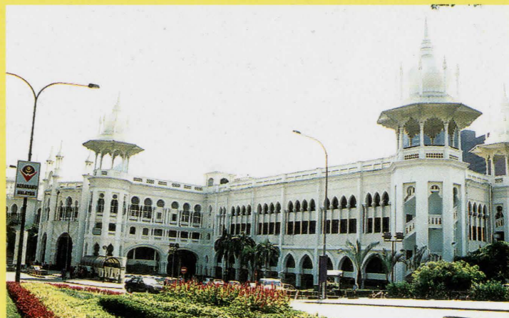
Bangunan Stesen keretapi Tanah Melayu - Gambar Berita Bandaraya
