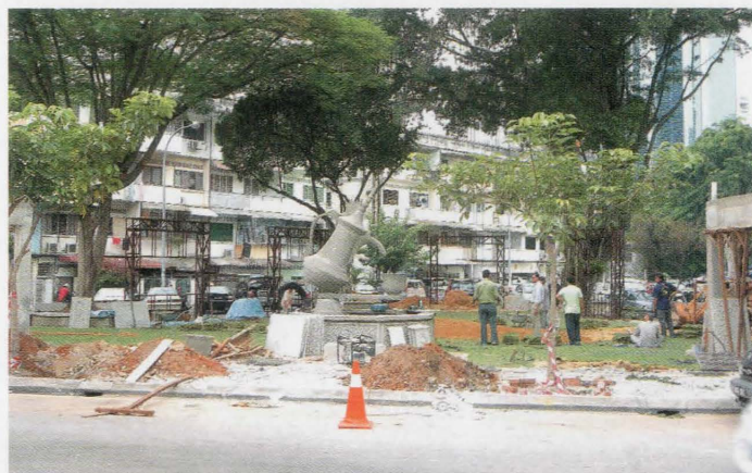
Taman mini yang dinamakan sebagai 'Ain Arabia' di Jalan Beremi/ Jalan Sultan Ismail yang sedang dalam pembinaan. - Gambar Berita Bandaraya
