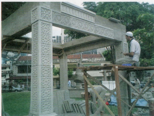
Kerja-kerja mengukir dilakukan oleh pekerja-pekerja mahir yang didatangkan khas dari negara Uzbekistan.
