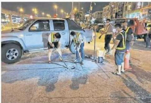
■線不足的情況下摸黑修路。由於修補路洞都是在晚上進行,眾人常在光
