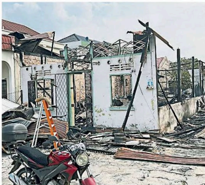
增江北区新村西篱笆路门牌1770号住家烧毁约90%。(鍾可婷攝)
