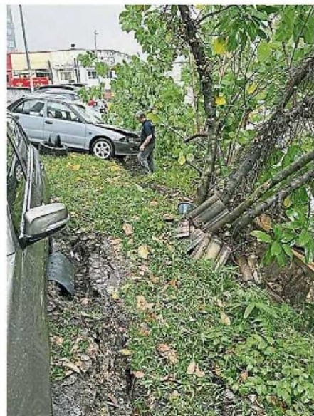
挡泥墙发生坍塌后，周遭有部分树木也快倒塌。（梁爱君提供）
