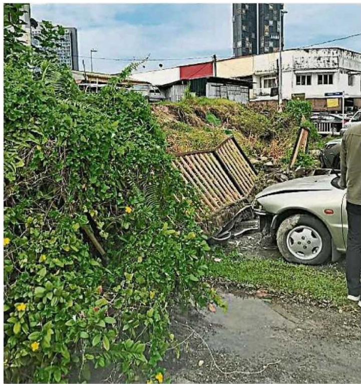
蕉赖友力花园榴梿路廉价组屋前的挡泥墙倒塌时，只有数辆停放在该处的废弃车辆受损。（梁爱君提供）
