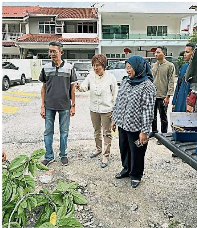
李俊豪（左起）、梁爱君及罗斯琳到挡泥墙坍塌事故现场巡视。（梁爱君提供）
