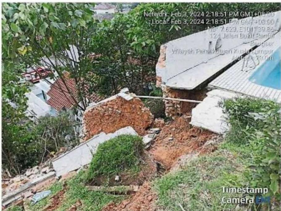
疑游泳池排水管破裂，以致水渗出令土壤松动酿土崩。（图由消拯局提供）
