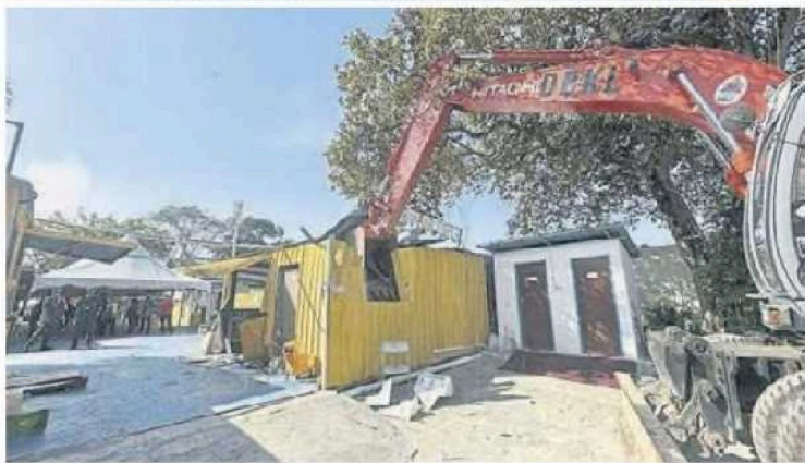
■ 市政局拆除非法建筑物。
