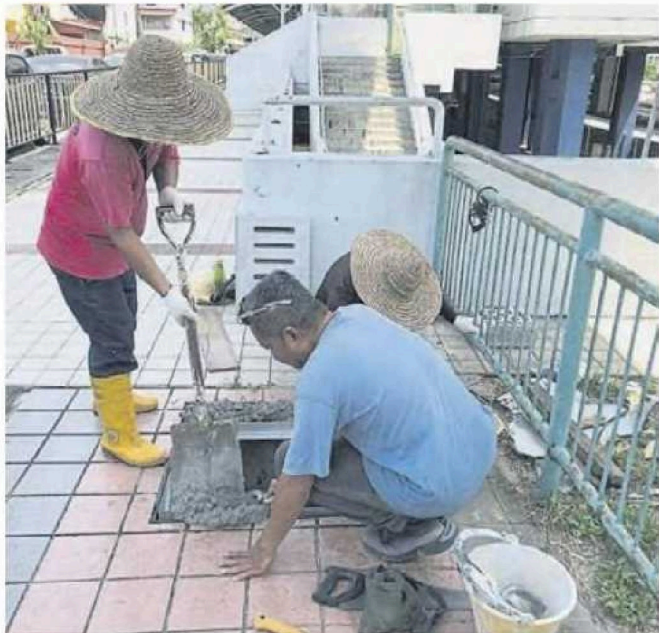
吉隆坡市政局已派出承包商维修人行道上一些已破损的地下沟渠盖。
