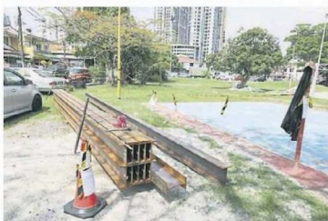
■有盖篮球场会采用的承重柱材料被放置在场地。
