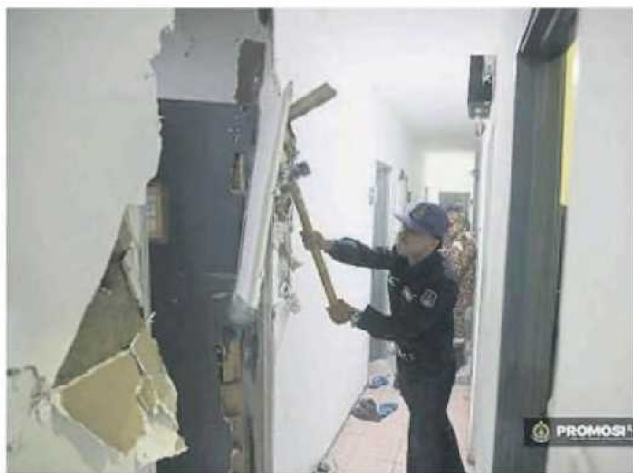
■执法人员大锤一挥，将商店违建部分拆除。
