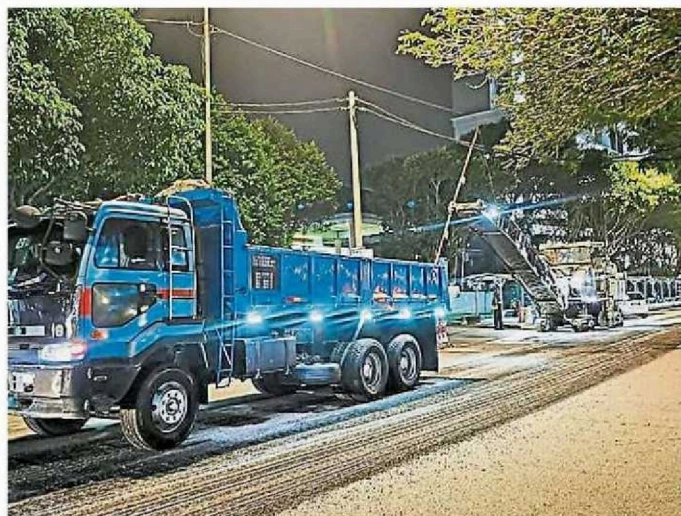
吉隆坡市政局在依达曼布特里公寓和依达曼舒特拉公寓之间的100公尺区间内进行“mill & pave”类型的道路修补。(黎正兴提供)
