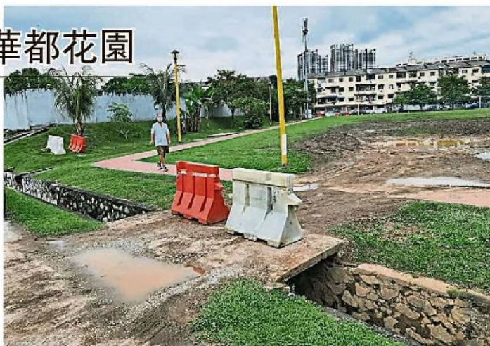
有心人贪图方便，非法搭建小石桥让外来车辆驶入停车。隆市政局上周已派员拆毁。（余保凭提供）
