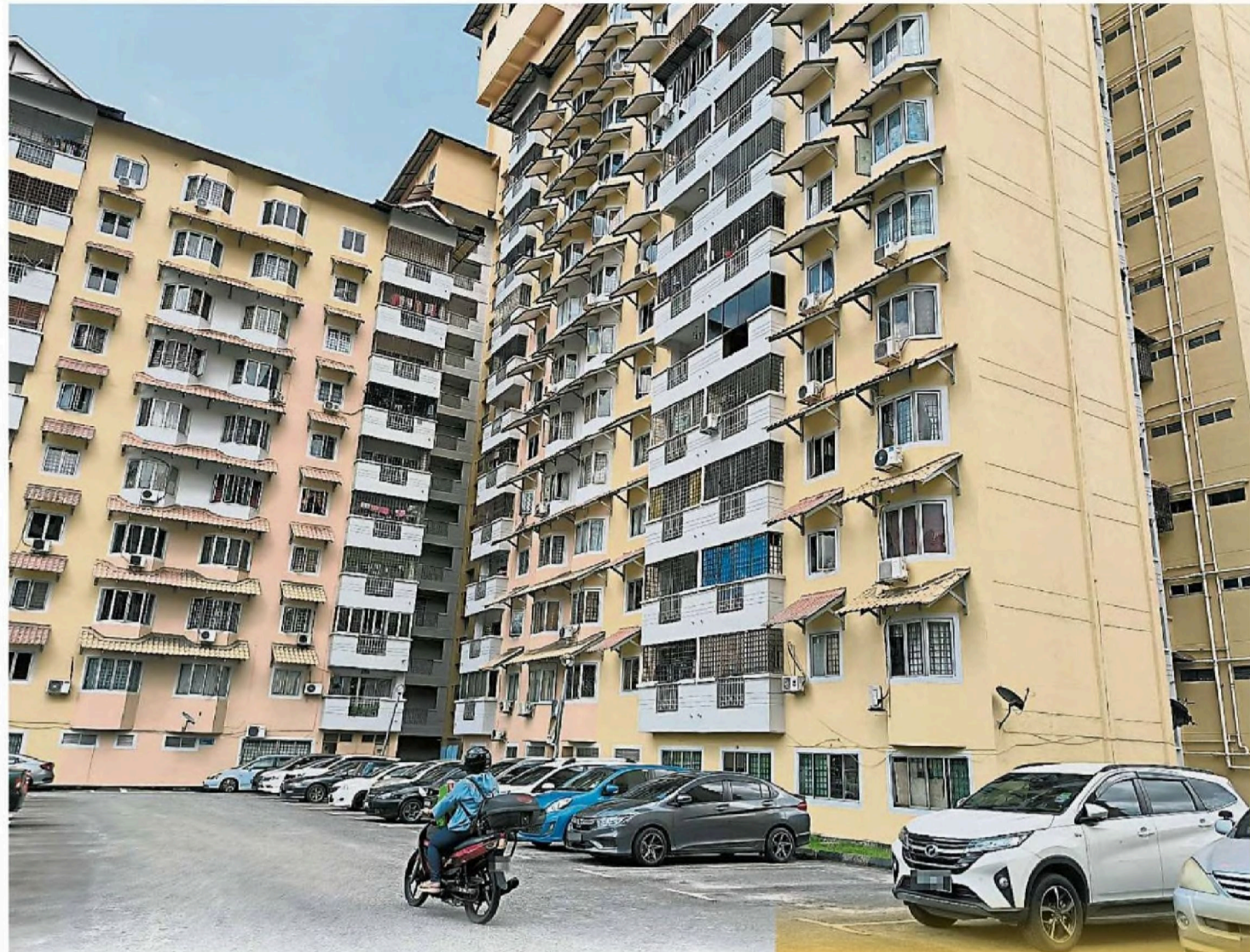
尽管武吉绍加纳公寓已有27年屋龄，不过管理费缴纳率高且定期粉刷外墙和维修基建，成为新山区管理典范之一。（苏韵翎摄）
