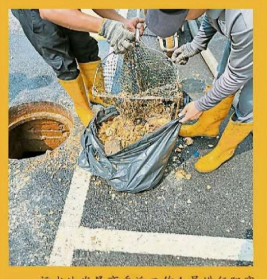
污水池发展商委派工作人员进行阻塞紧急疏通工作。（管委会提供）
