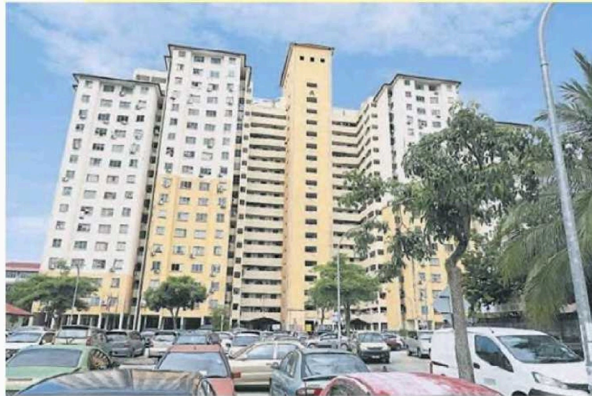
■甲洞横街人民组屋升降机屡故障，令居民烦不胜烦。（档案照）
