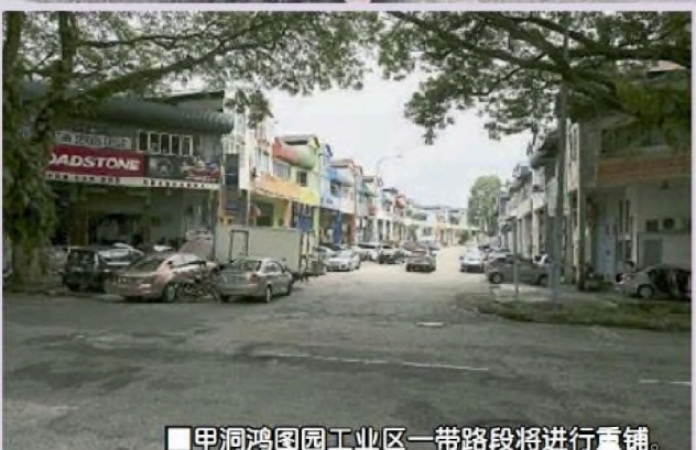
■甲洞鸿图园工业区一带路段将进行重铺。
