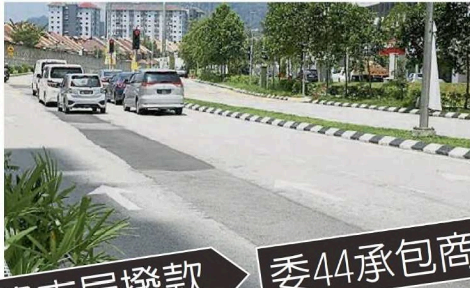
■过去承包商仅是局部铺路，造
