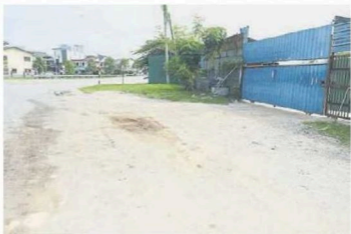
■仓库外的道路损坏,下雨天容易积水。
