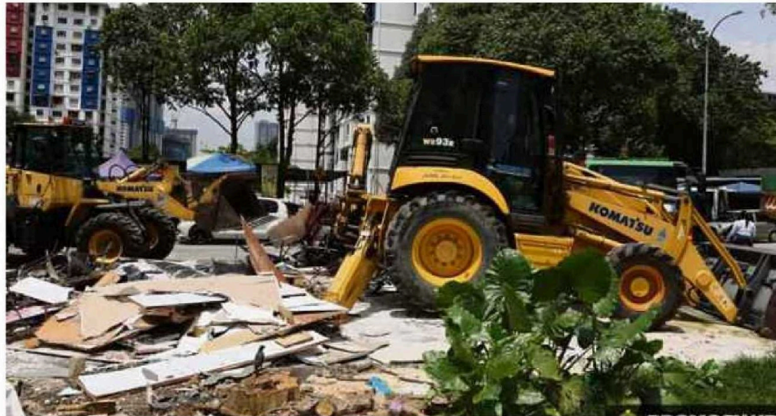
DBKL merobohkan gerai penjaja tanpa kebenaran di Jalan Pantai Permai, Projek Perumahan Rakyat (PPR) Kerinchi, Kuala Lumpur, kelmarin.
