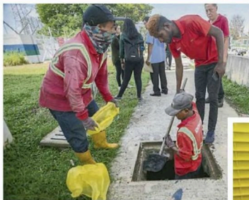
■固體廢料管理機構派員清理溝渠。
