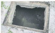
■甲洞區溝渠沙石堆積,狹窄且淺。
