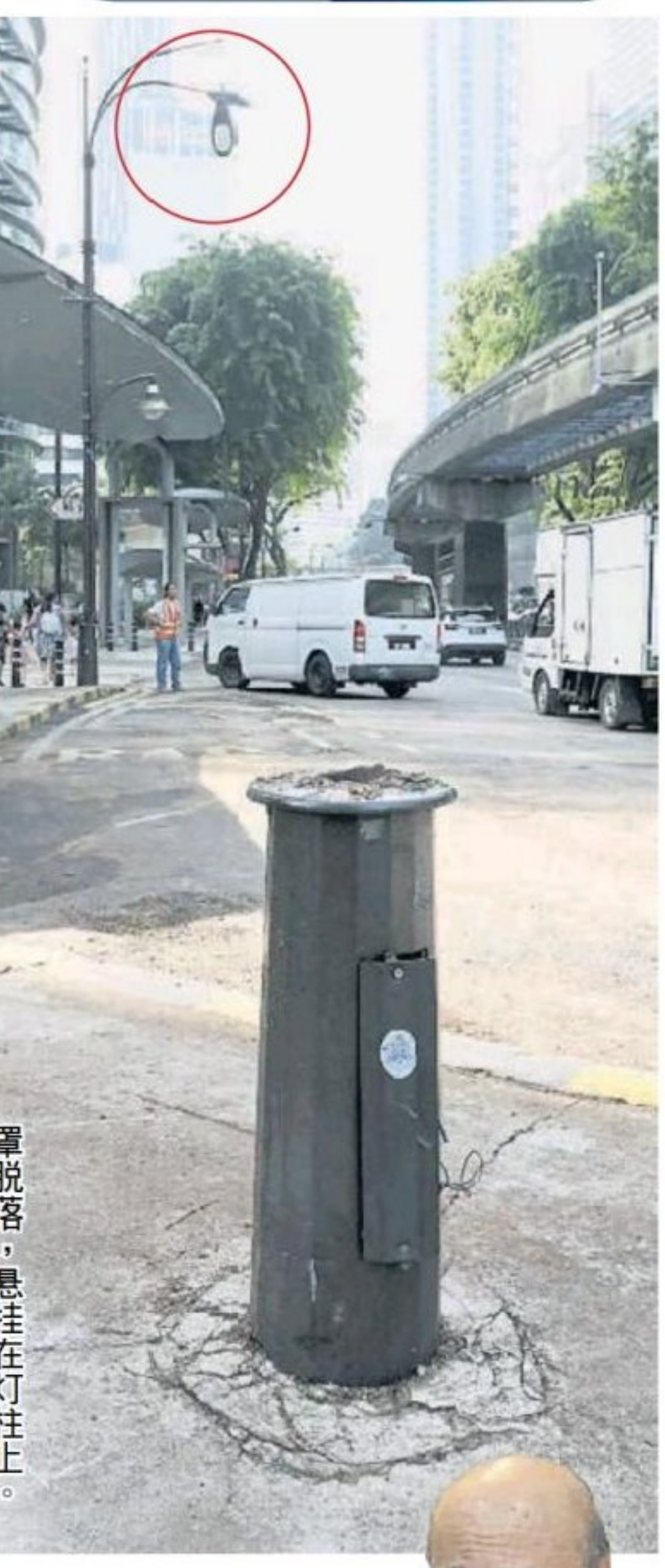
■个被拦腰截断，悬挂在灯柱上。两个灯柱被大树压损，一
