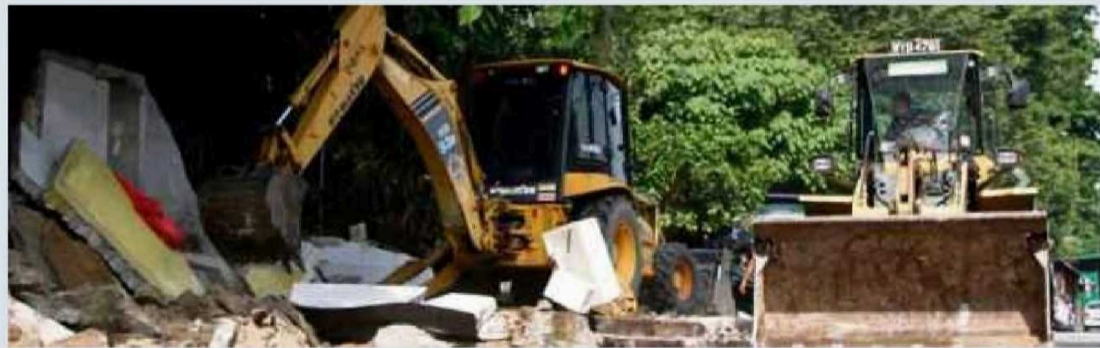
DBKL merobohkan struktur kekal berbumbung tanpa permit dan pindah halangan di Jalan Hang Tuah 4, Salak Selatan, kelmarin.
