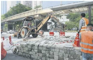
■的巴士候车站。 工人正在修复破裂的地砖及被大树砸毁
