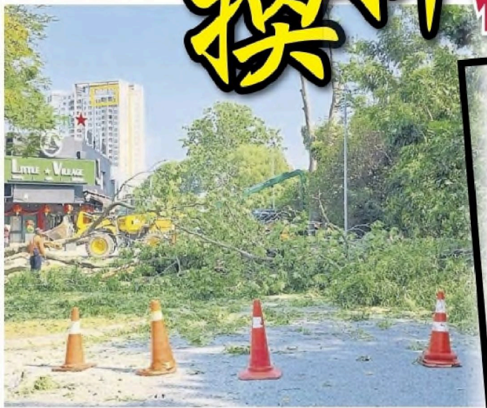
怡保市政厅已鉴定怡保市内200棵的桃心花木，逐步以黄焰木替代，减低倒塌风险。(受访者提供)
