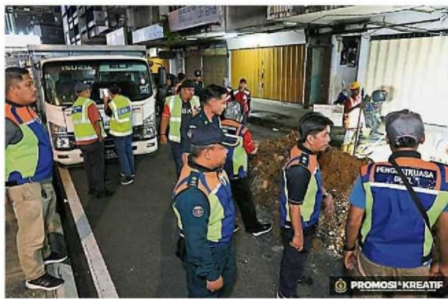
执法官员到挖路现场视察，一旦发现没根据SOP做事，就开出罚单。（取自隆市局脸书）
