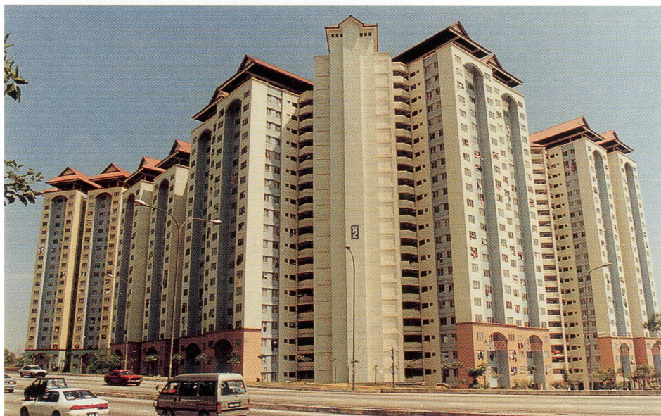
Perumahan Awam DBKL yang menjadi idaman mereka yang berpendapatan rendah.
