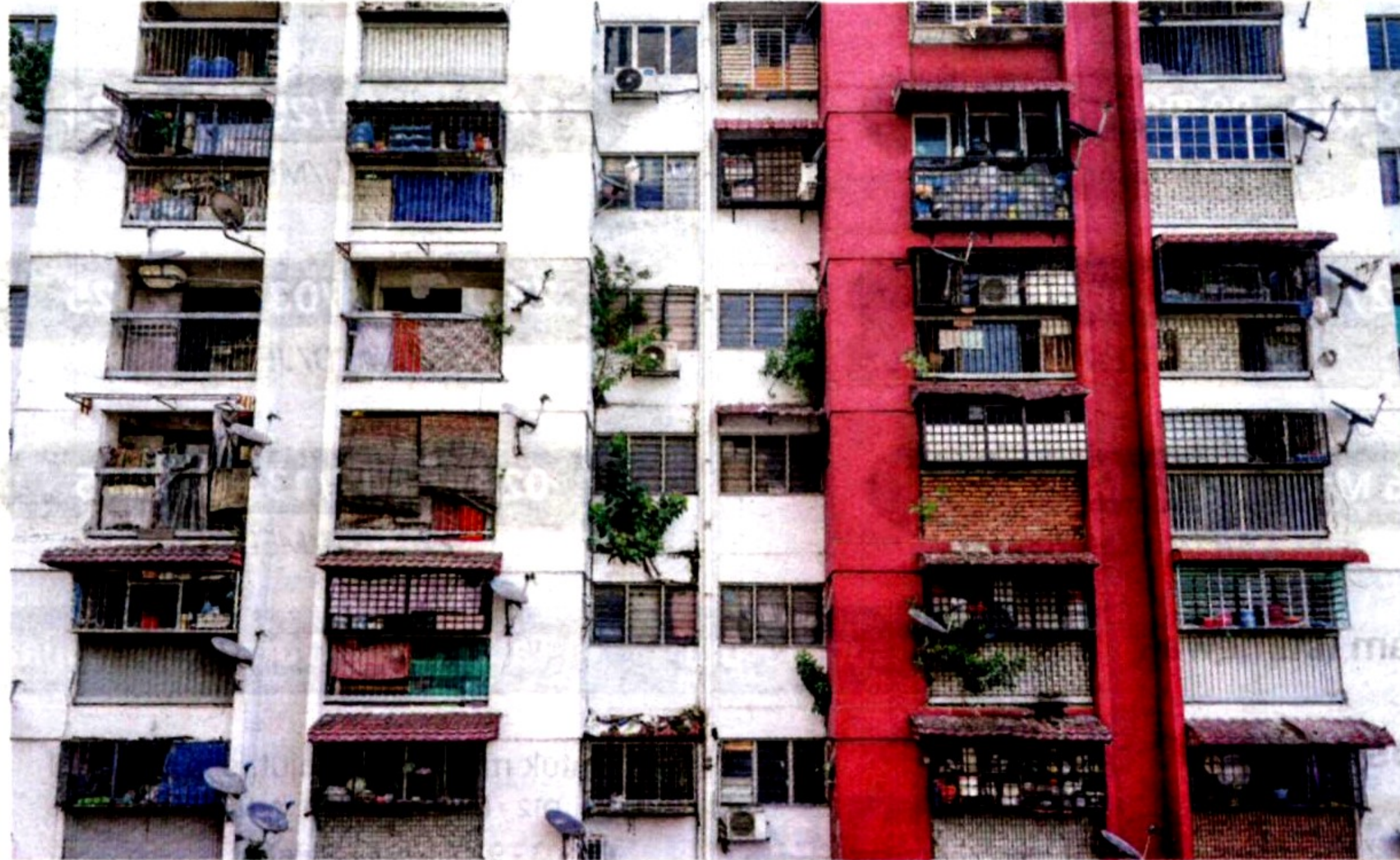
POKOK liar yang tumbuh di dinding bangunan mencacatkan pemandangan di Program Perumahan Rakyat (PPR) Sri Sabah, Kuala Lumpur. - MINGGUAN/MOHD FARIZWAN HASBULLAH
