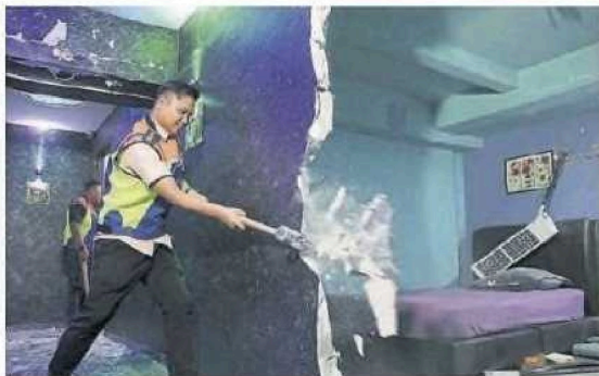
■ 营色情架布，执法人员挥大锤击破「炮房」，非法按摩中心将单位割成57间「炮房」，经
