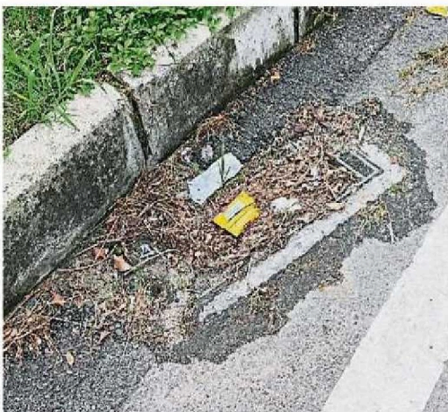
位于斯里白沙罗镇的甲洞路/瓜雪路，许多沟区都被泥沙、树叶及垃圾堵住，无法顺利排水。（伍思薇摄）
