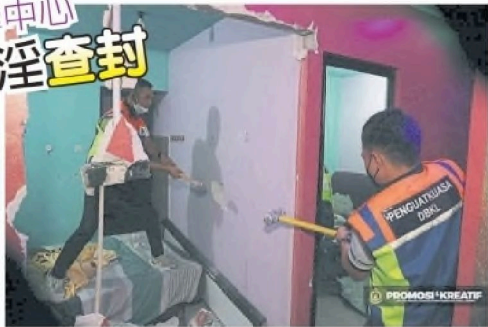
■市政局执法人员挥动巨锤动手拆除室内建筑结构。 （图摘自市政局 面子书）
