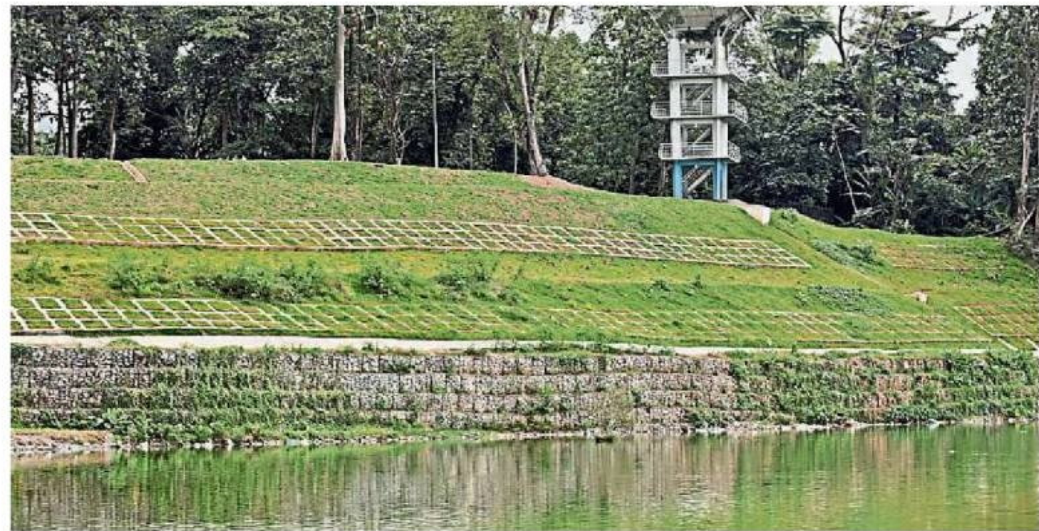
▲吉隆坡市政局把山坡上的樹木砍掉後，進行框格填土植被工作，以此方式固定山坡泥土。
