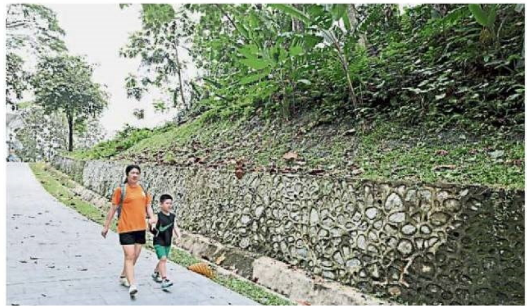
▲前往山上瞭望台的步行道及旁邊山坡的擋土牆，之前都已被損及崩塌，如今一切都已修復好。
