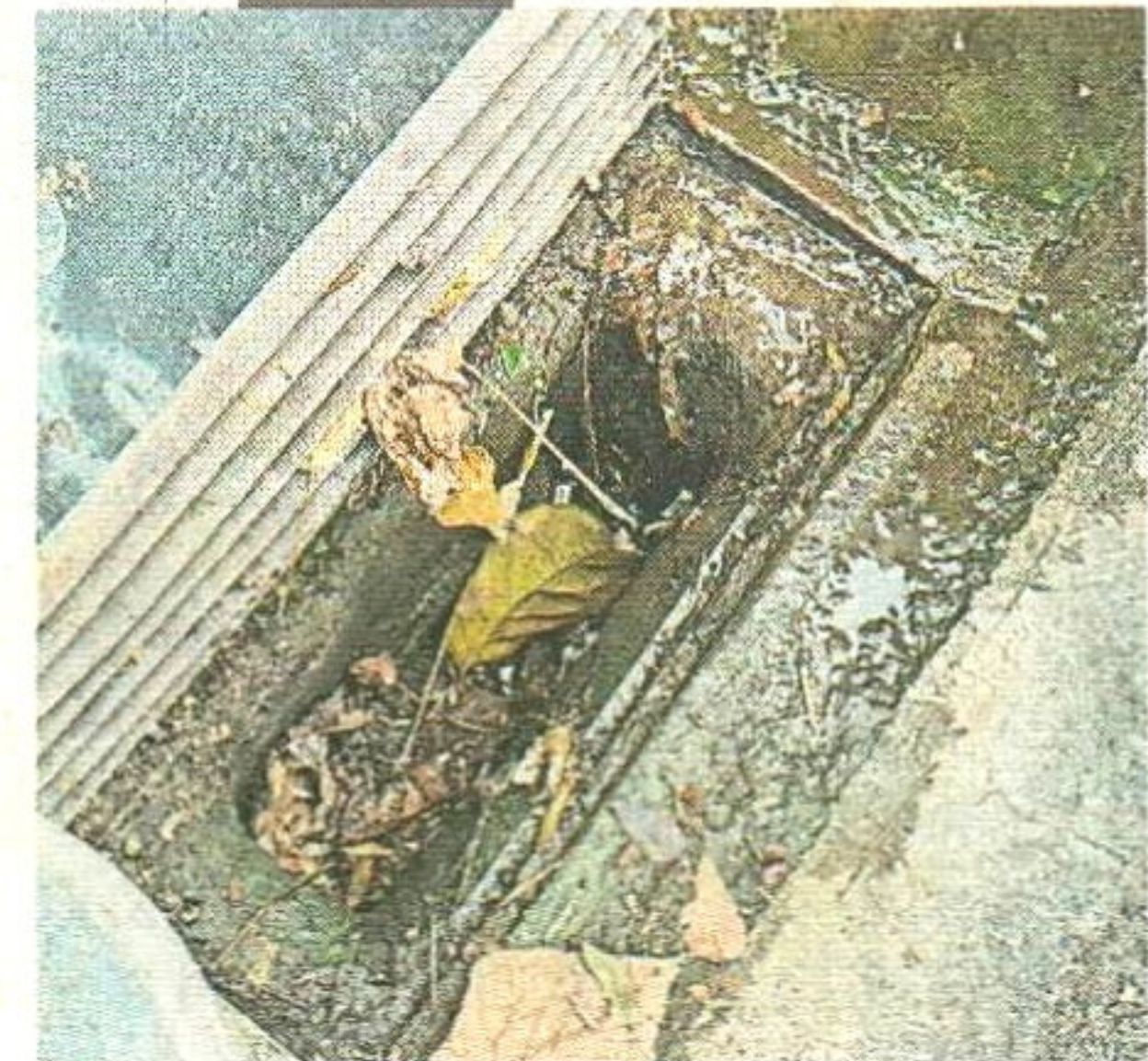
阿曼布特拉1路的沟渠内已经堆积污泥、树叶和油渍，相信已好一段时间不曾清理。
