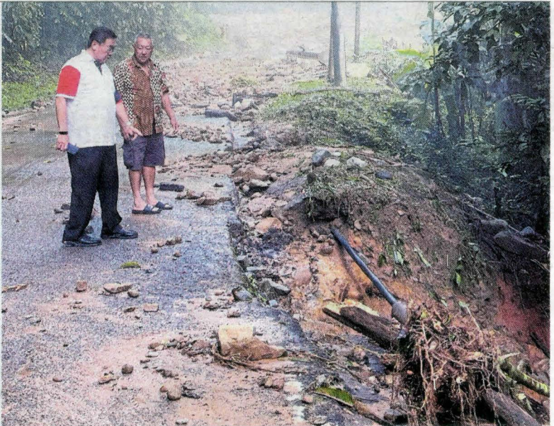
Su (kiri) meninjau lokasi kejadian jalan runtuh sepanjang 50 meter di laluan FT68, Jalan Bentong-Kuala Lumpur, semalam.
