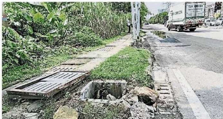
路边随处可见挖掘工程后，留下大坑洞。
