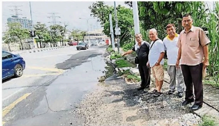
余保凭（右）和居民投诉承包商，没有认真履行任务，导致路面有坑洞，凹凸不平，引发积水。
