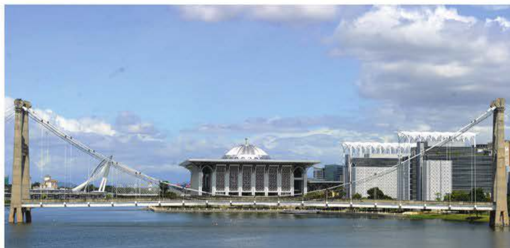
BEGINILAH keadaan jambatan yang sepatutnya menjadi landasan Monorel di Presint 3 terbengkalai setelah projek rel itu dihentikan pada tahun 2004.
