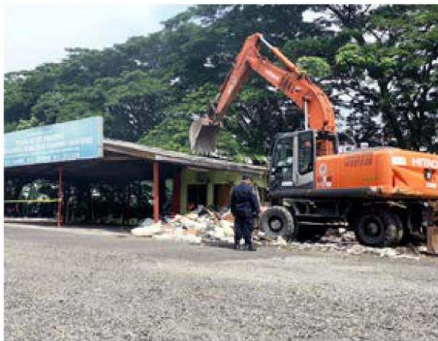
KERJA merobohkan premis yang dibina di atas tanah milik kerajaan tanpa izin oleh PPTGWPKL.
