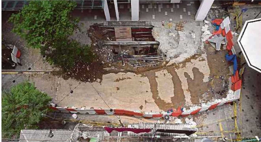
Lokasi kejadian tanah jerlus di Jalan Masjid India yang mengorbankan seorang wanita warga India pada pertengahan Ogos lalu.
