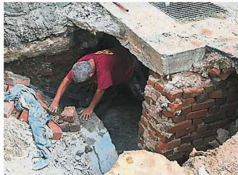
市政局将会更换破裂的水涵，接着再处理路洞及重铺路段。
