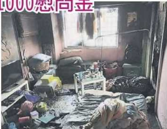
■鵝唛斯迪亞人民组屋日前发生火灾，共4个单位遭殃，走廊墙壁和天花板亦遭损坏。
