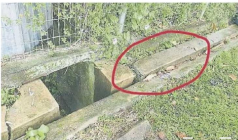
■增江北区增江实达1路及5路排水沟发生塌陷（红圈），使得排水系统受影响。
