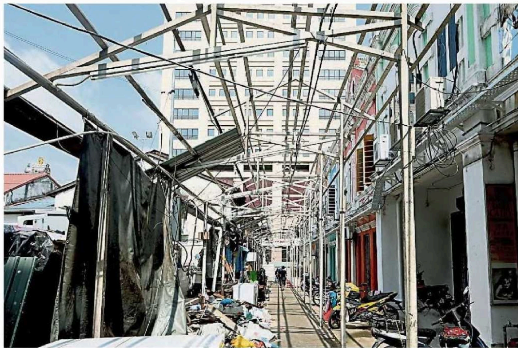
李霖泰菜市场正在进行第一阶段的拆除与提升工作。
