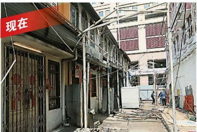
李霖泰菜市场衔接中华巷部分路段的棚盖已被拆除。
