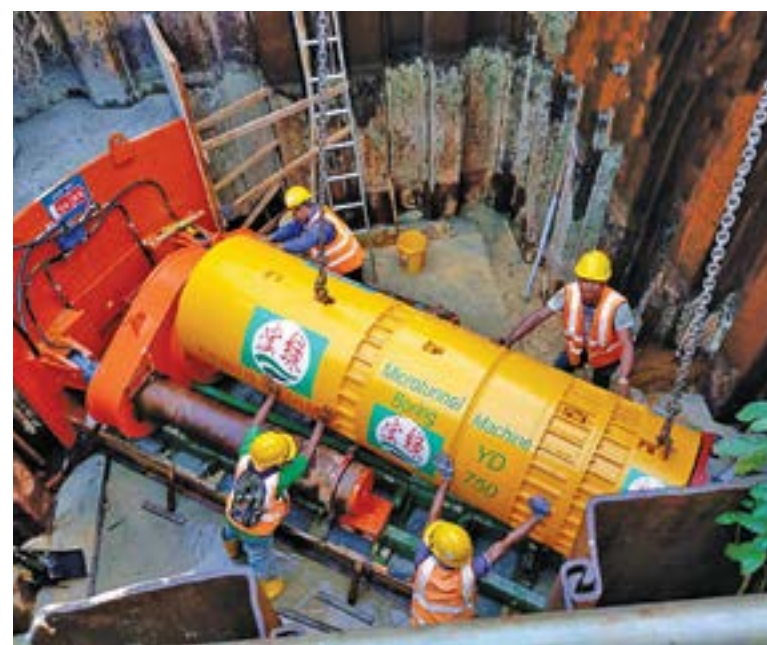
KAEDAH sambungan paip (pipe jacking) akan digunapakai di dalam sistem pengairan Kuala Lumpur. - Gambar Khidmat Hijau
