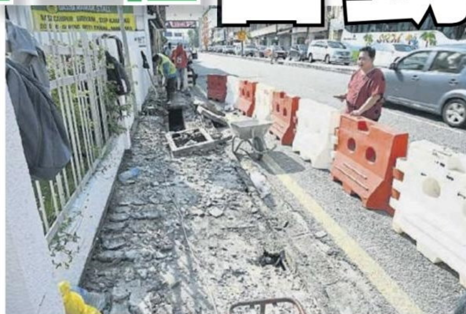
■蔡美丽带媒体巡视半山芭巴刹的提升工程。
