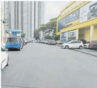
严重损坏的柏油路面目前已经完成铺设。
